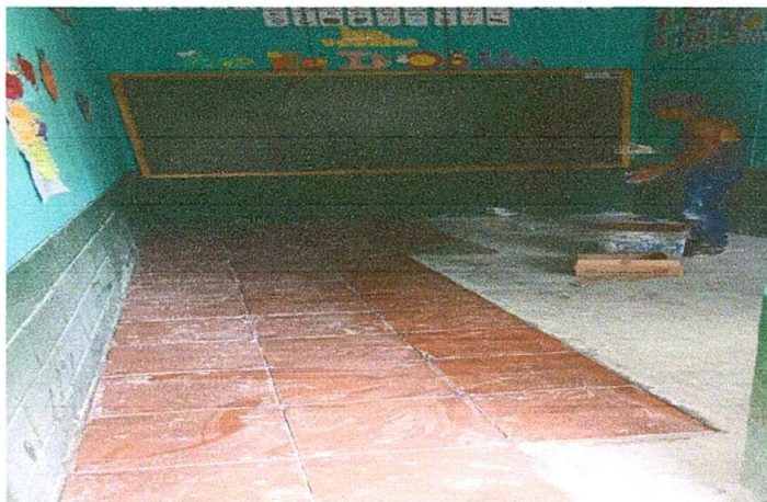
Foto 4: Sustitucion de piso
